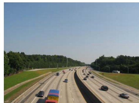
I-285 corridor in Central DeKalb
